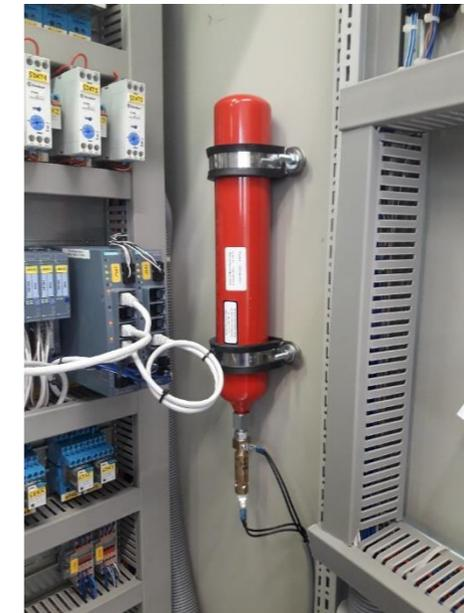
AMFE-Zylinder mit automatischer Mini Feuerlösch-Einheit, eingebaut in einem Schaltschrank
