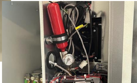
Die verbaute S-AMFE im Snackautomat
